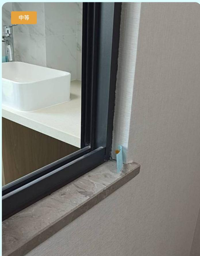
★ 窗洞两侧墙布毛边，脱落
