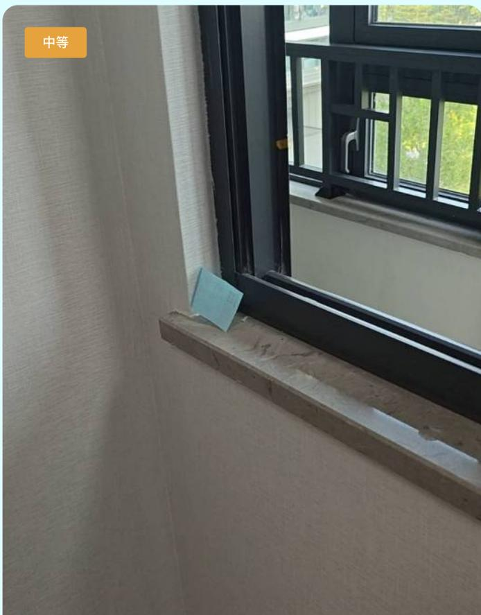
★ 窗洞两侧墙布毛边，脱落
